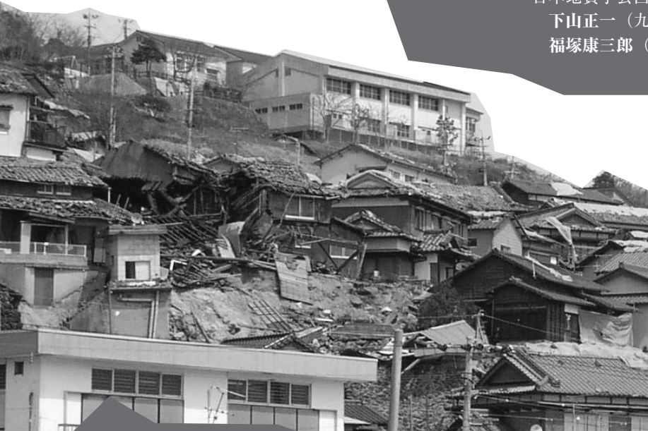
写真1 福岡市西区玄界島の 家屋被害（全壊、半壊、屋根瓦の落下）
